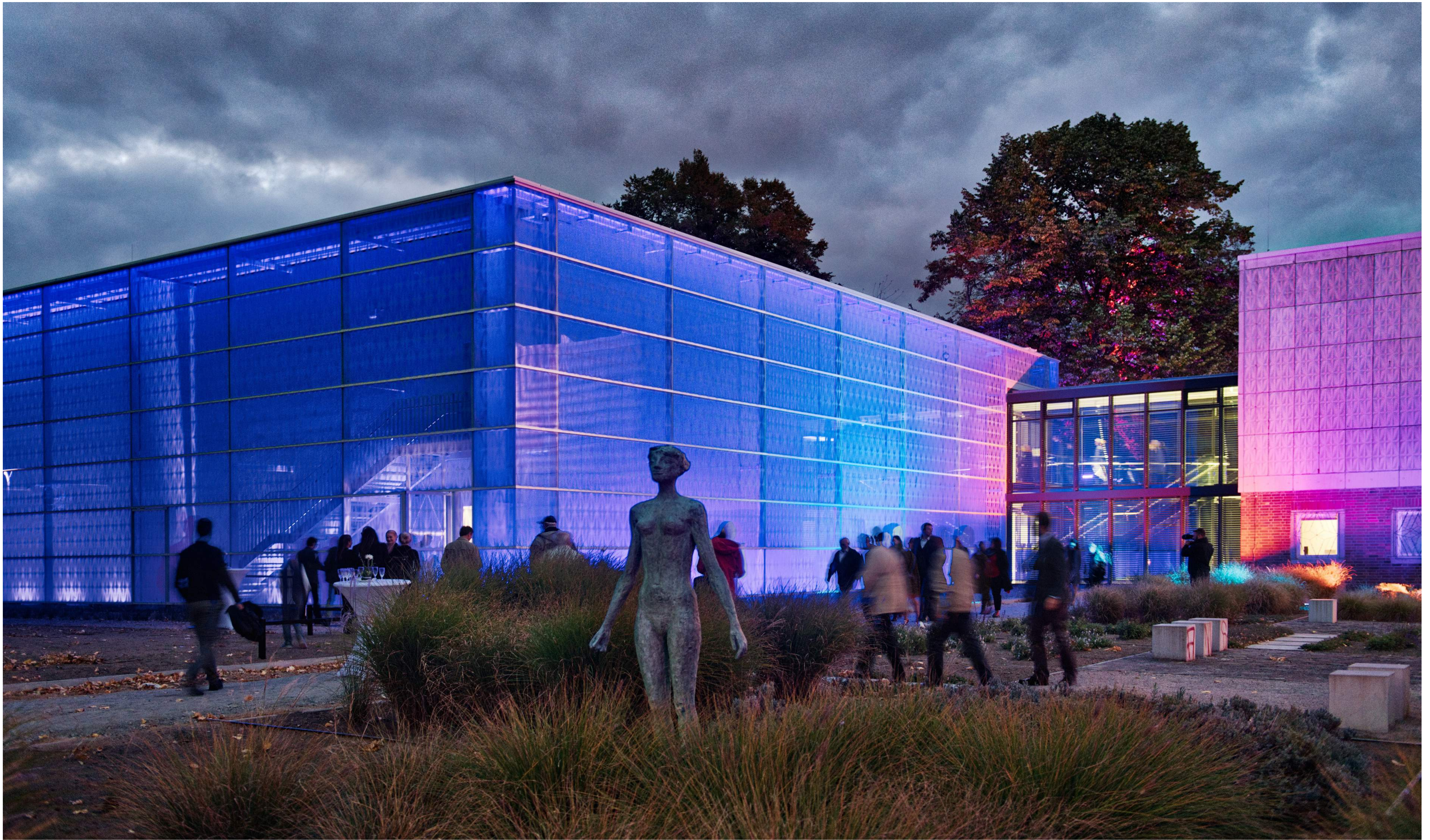
Neubau Schaudapot mit Sonderbeleuchtung bei Nacht
